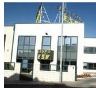
Sede central de ESV.
